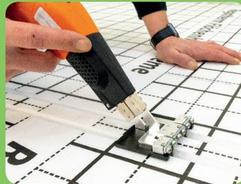
**Einbrennen der Zuleitungen mit dem Nutenschneider**
